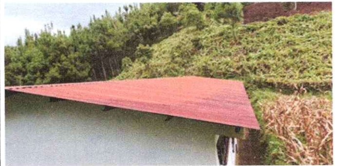
Foto 8: cambio de láminas Aula No. 3, 4; bodega y dirección.
