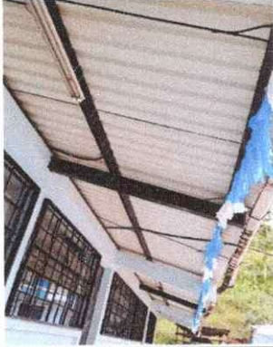
Foto 7: Cambio de láminas de la bodega y dirección.
