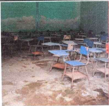
Foto 05: Sustitución de piso rústico a piso cerámico. Aula No. 2
