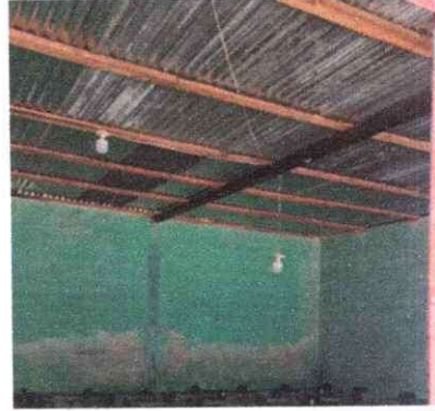
Foto 2: Cambio de techo. Aula No. 2
