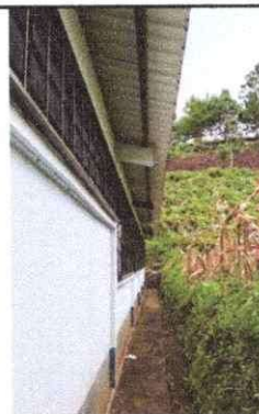
Foto 12: Colocación de Canal de ALUZINC 20.50 ML,
