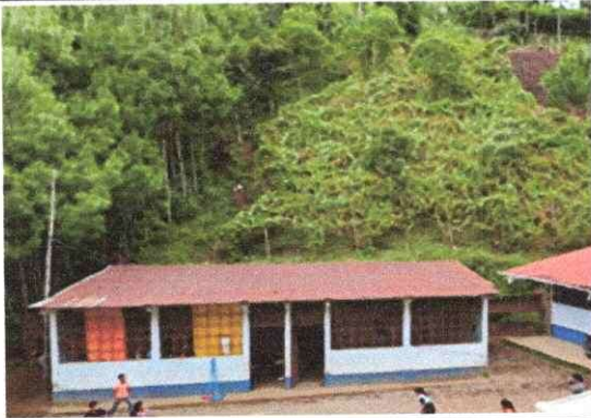
Foto 3: Cambio de techo del Aula No. 1 y 2.
