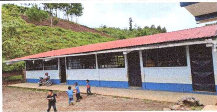
Foto 11: Sustitución de canal PVC por uno de ALUZINC, 20.50 ML.
