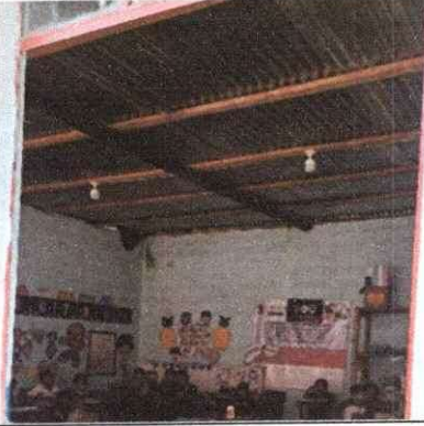
Foto 1: Cambio de techo. Aula No. 1
