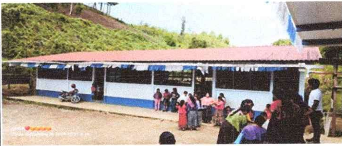
Foto 9: cambio de láminas Aula No. 3, 4; bodega y dirección.
